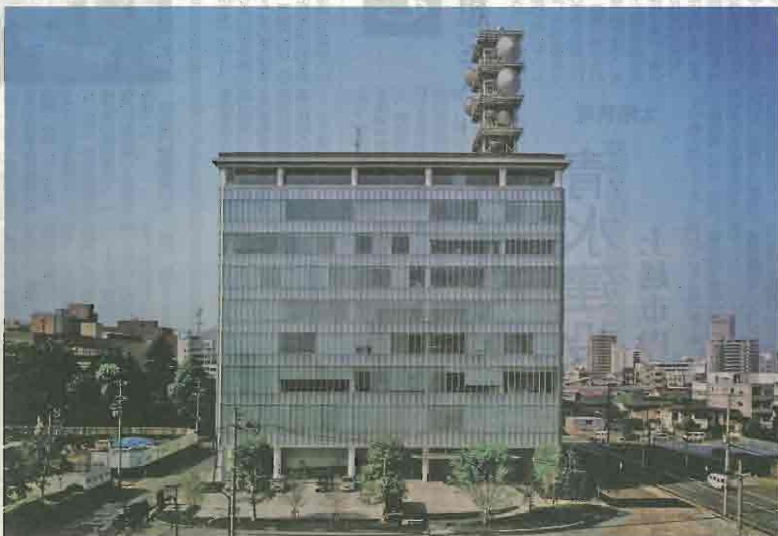
北側正面全景
