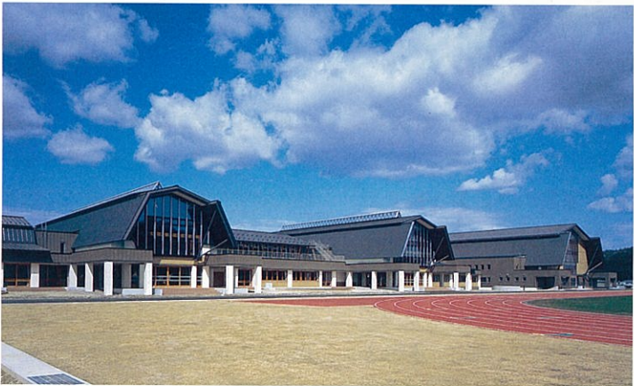
東通村立東通小学校（施工場所：青森県下北郡東通村）
