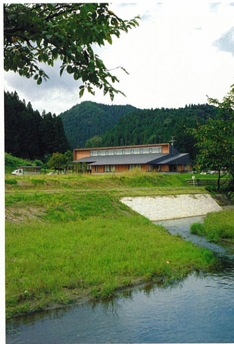
外観2 敷地北側の鮫川沿いの桜並木越しにみる診療所
