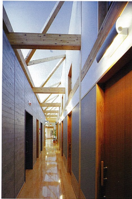
廊下1 X線室を囲むコンクリート打放の壁面に、木造架構が重なる廊下。右側が処置室
