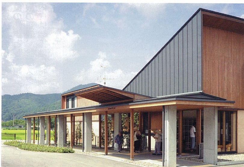
クリニック入口 クリニック玄関前の雁木空間。調剤薬局へつながり、また送迎バスの待合いなどにも利便性を示す
